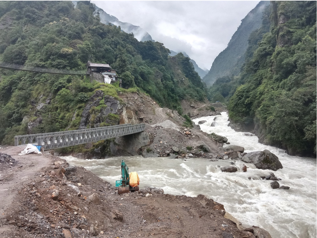
कञ्चनजङ्घा जाने सडकमा बेलिब्रिज : विश्वको तेस्रो अग्लो शिखर कञ्चनजङ्घा जाने सडक ताप्लेजुङको फक्ताइलुङ गाउँपालिका-६ तमोर खोलामाथि निर्माण सम्पन्न भएको बेलिब्रिज । तस्वीर : दिलकुमार लिम्बू/रासस
