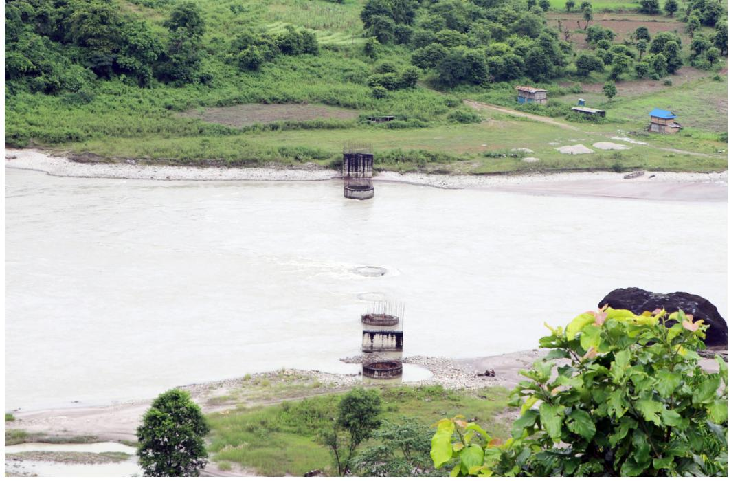
१२ वर्षसम्म अलपत्रमा परेको पुल: संखुवातभा र भोजपुर जोड्ने लम्सुवाधाटस्थित अरण्ण नदीको अलपत्र पक्की पुल। १२ वर्ष बित्ता समेत अरुण नदीमा पक्की पुल निर्माण हुन सकेको छैन। पक्की पुल निर्माणको ठेक्का पाएको स्वच्छन्द निर्माण सेवाले पुलको जमिनमुनिको पिलर बिल निर्माण गर्ने क्रममा १२ मिटरमै छट्टान भेटिएको भन्दै अलपत्र छाउको छ। तस्वीर: रासस
